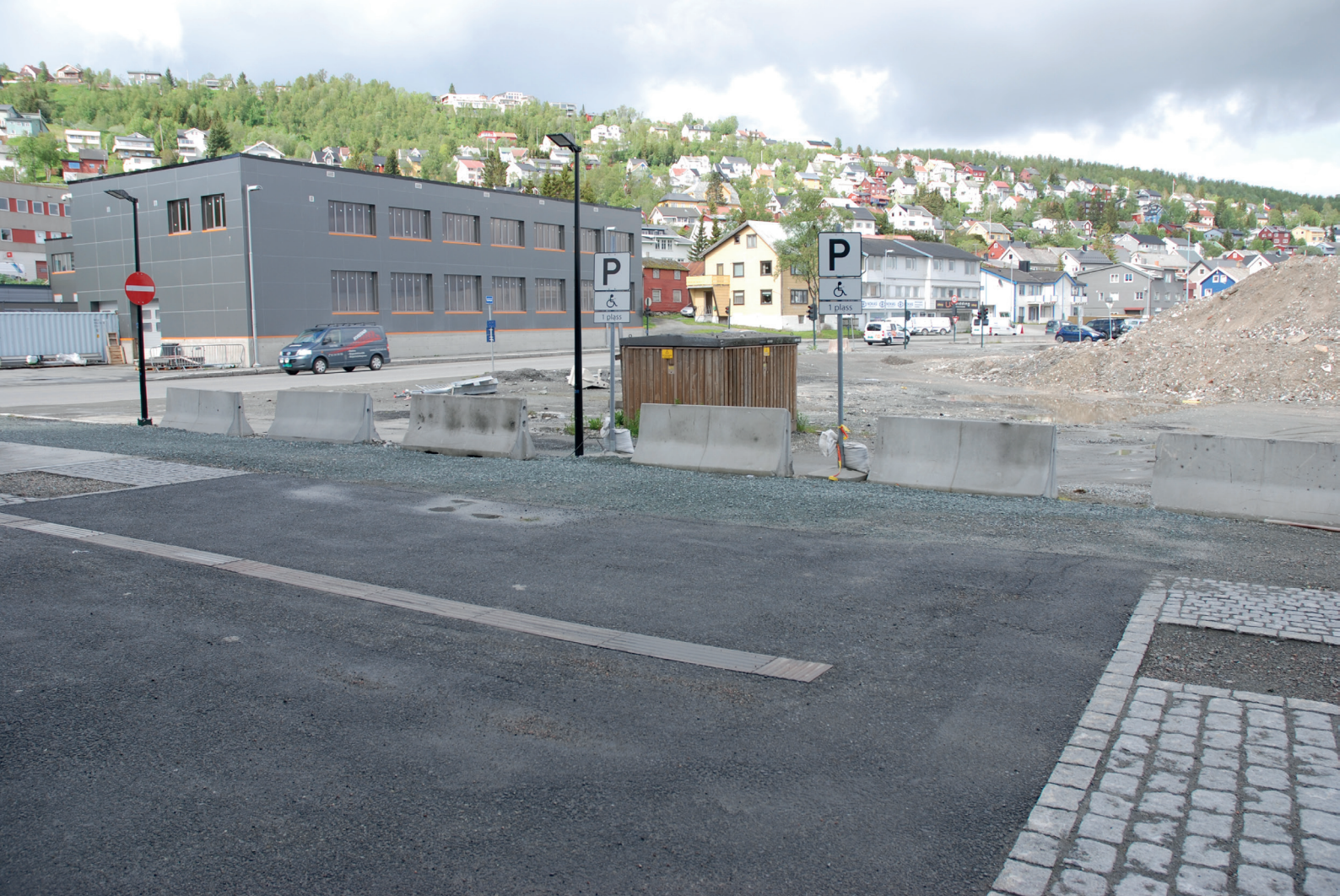
Parkering for forflytningshemmede ved hovedinngang
